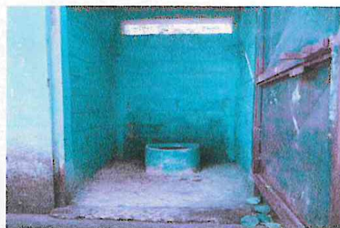
Foto 4: SUSTITUCIÓN DE INODORO
