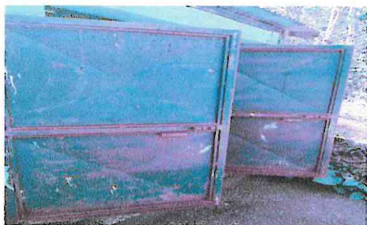
Foto 3: SUSTITUCION DE PUERTAS DE BAÑO
