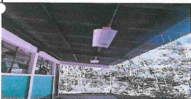
Foto 5: SUSTITUCIÓN DE LÁMPARAS
